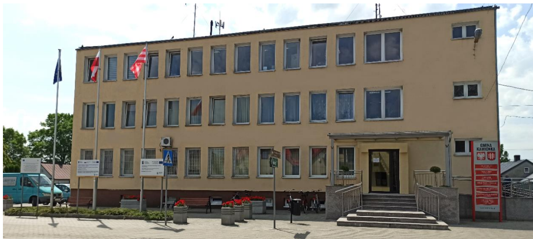
Fot.2. Budynek Urzędu Miejskiego
